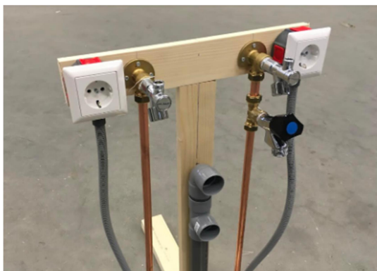
Afbeelding toont de gewenste ordelijke installatiewijze van het leidingwerk (let op: het benodigde leidingwerk is situatieafhankelijk)
